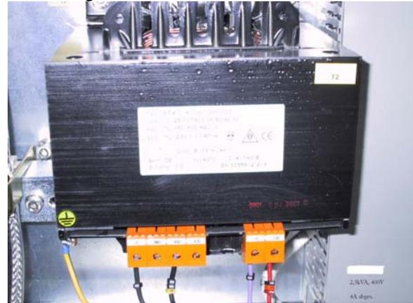
Der in Bild 1 gezeigte 2,5kVA Trafo kann auf der 400V Primärseite, trotz dem relativ niederen Einschaltstrom dann zum Beispiel nur mit einem C16 Ampere Schutzschalter abgesichert werden. Das ist der 2,5 fache Nennstromwert des Trafos.
